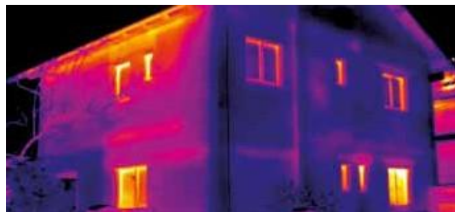
Обследване на сгради: Откриване на енергийните загуби
